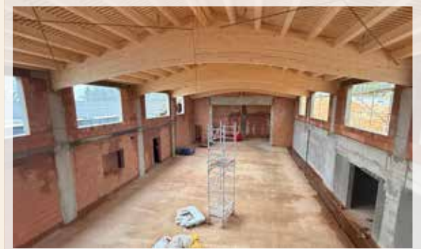
Mehrzweckhalle im Bau
