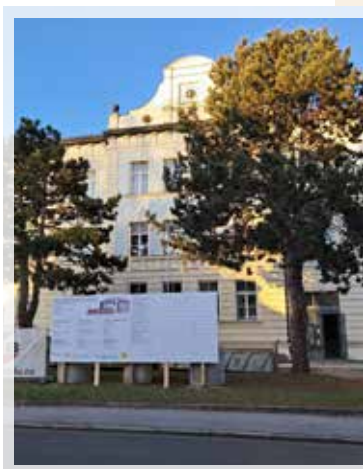
Sanierung Grundschule Ritter Tuschl
