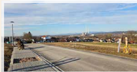
neues Baugebiet „Am Gatterntürl“
